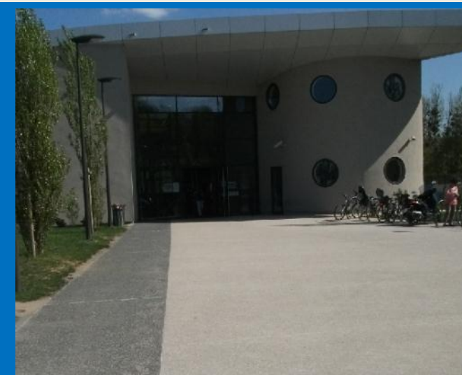
6) Illustration d'un cheminement accessible avec contraste tactile et visuel (en partie gauche)
