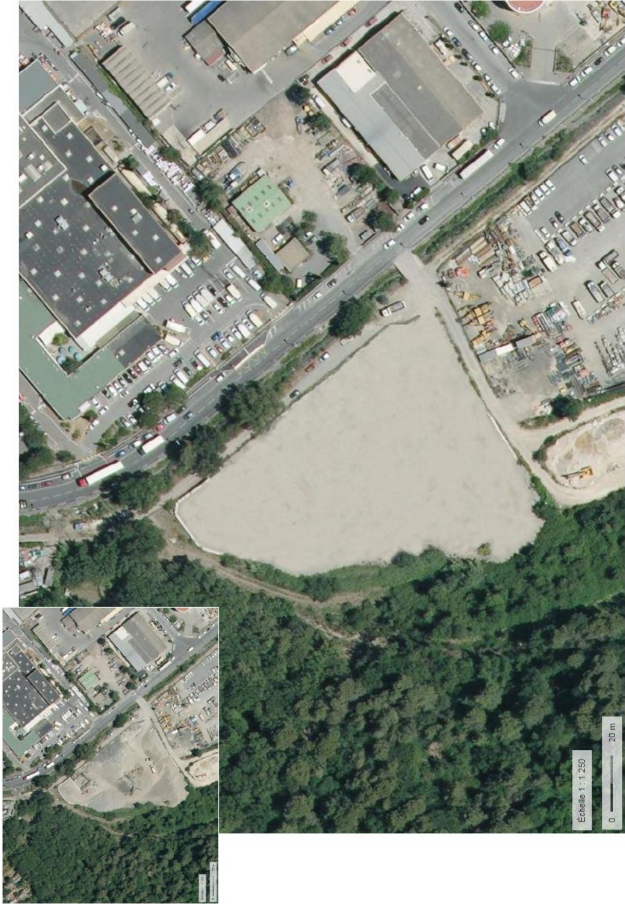
Vue aérienne de l'état final du site après restitution (état actuel en médaillon)
