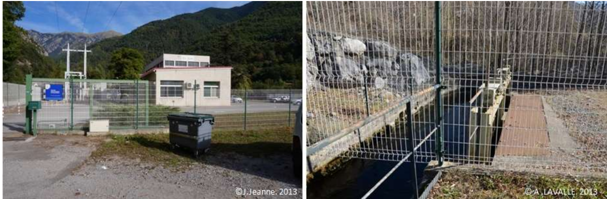
Illustration 50 : Usine hydroélectrique de Roquebillière d'EDF (à gauche) / Ouvrage de restitution de l'usine EDF et prise d'eau de la Régie d'électricité de Roquebillière (à droite)
